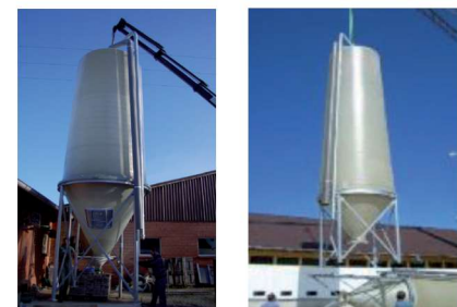
Einfache und sehr schnelle Montage der Standardsilos durch umfangreiche Vormontage
