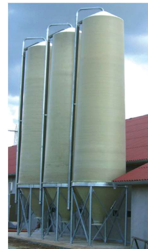
3 x 30 cbm Silos für Masthähnchenstall
